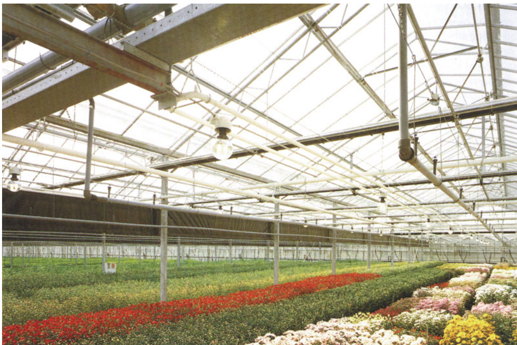
Abb. 23 Mit SL-AGRO bestückte Anlage für photoperiodische Belichtung
