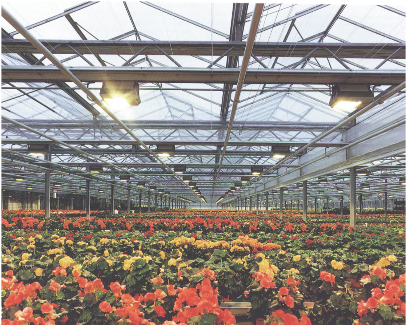
Abb. 17 Belichtung mit Hochdruck-Natriumdampflampen zur Förderung der Photosynthese und des Photoperiodismus
