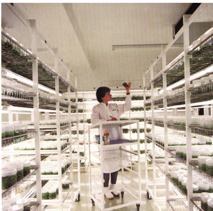
Abb. 24 Gewebekultur-Betrieb in Bremen, Bundesrepublik Deutschland. Die Anlage besteht aus 210 TL-D HF-Lampen 50 W, Farbe 830. Das HF-Lichtregelsystem wurde gewählt, da die hier gezogenen Pflanzenarten verschiedene Bestrahlungsstärken und Bestrahlungszeiten benötigen
