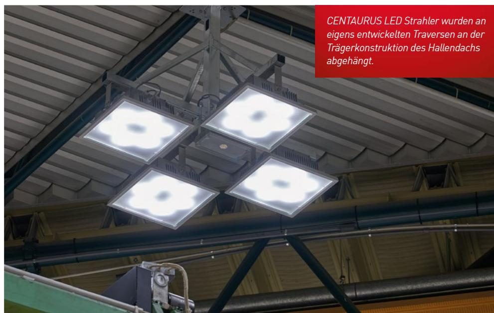
CENTAURUS LED Strahler wurden an eigens entwickelten Traversen an der Trägerkonstruktion des Hallendachs abgehängt.
