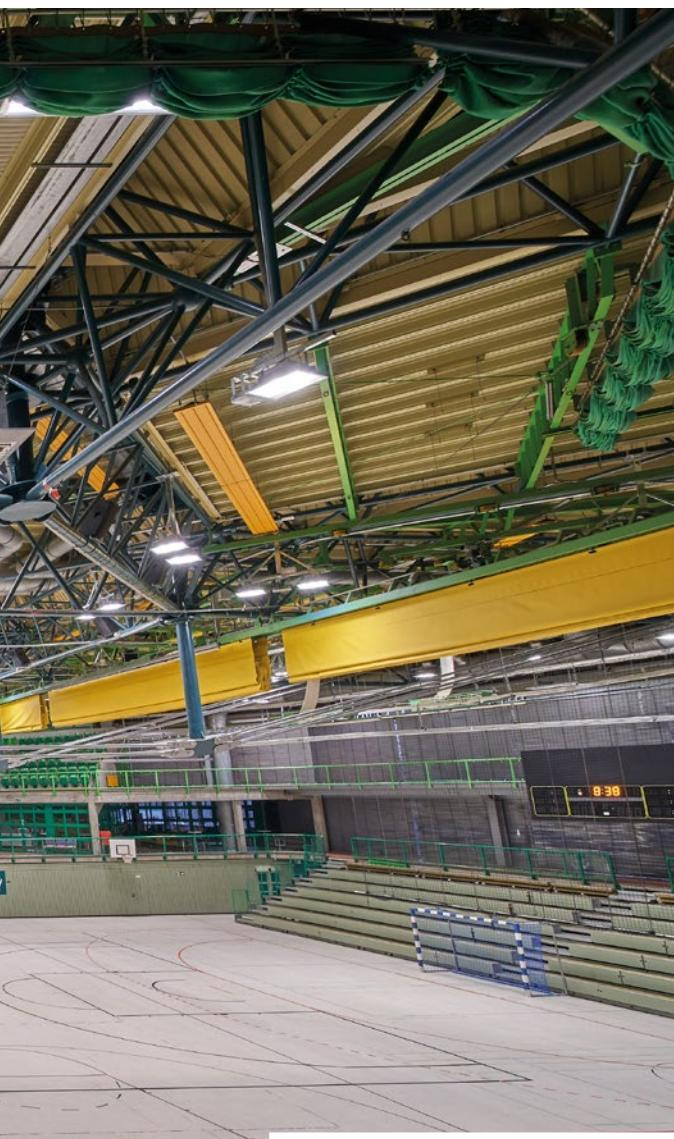
Aus effizienten LED-Leuchten, maßgeschneiderten Abhängungen und einem Lichtmanagement, das nicht nur vielseitige Lichtszenen bereitstellt, sondern auch an die zentrale Brandmeldeanlage angebunden ist, bestand das Gesamtpaket, das NORKA und NORKA Automation für die Sanierung der Unihalle Wuppertal geschnürt haben.
