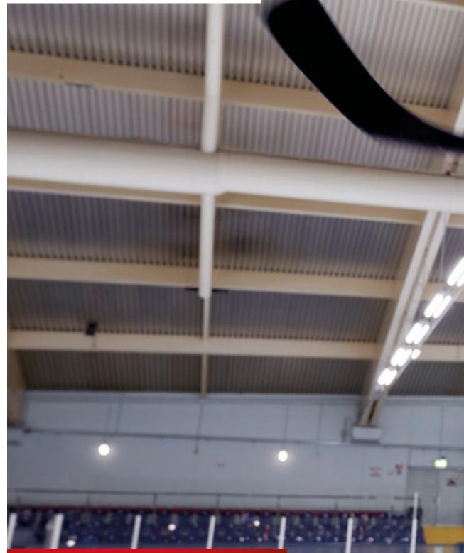
*Die Leuchten sind mit Abdeckungen aus bruchsicherem PC Tropal® ausgestattet, um ungewollte Beschädigungen oder Brüche in einer Eissporthalle zu vermeiden.*
